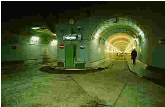
Blick vom Schachtgebäude in den alten Elbtunnel Foto: S. Bardua
